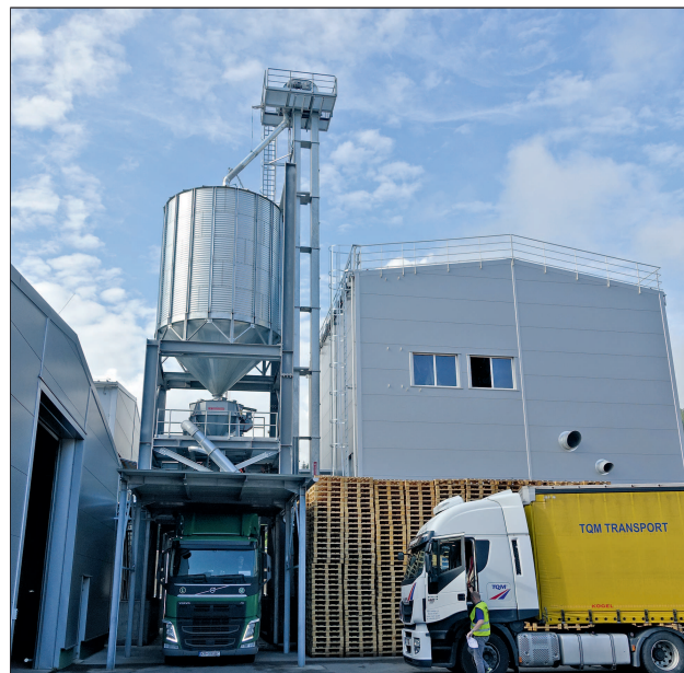
Außenansicht der Pelletproduktion mit LKW-Verladung
